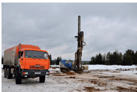
Рис. 2а. Комплекс для выполнения струйной цементации в многолетнемерзлых грунтах Fig. 2a. Complex for performing jet cementation in permafrost soils
