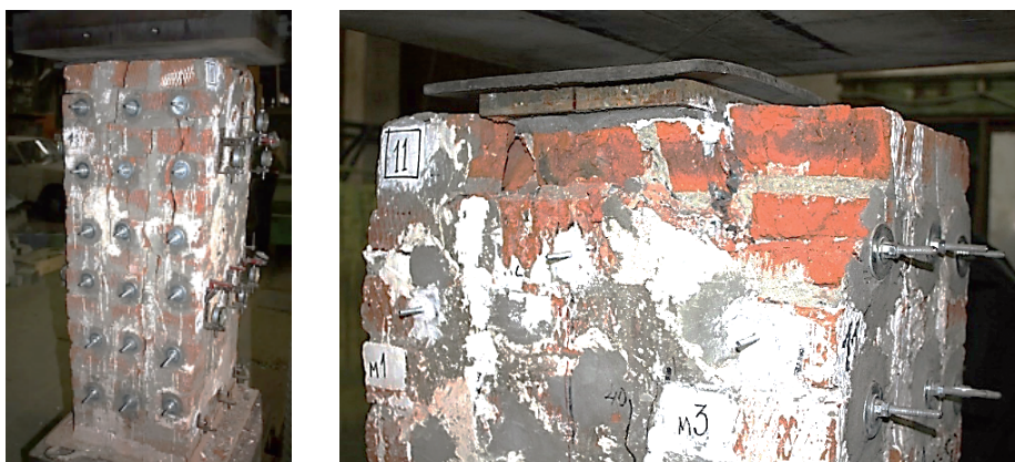
Рис. 14. Образец из современного кирпича, имитирующий получивший трещины после 1-го этапа испытаний на местное сжатие, усиленный инъекцией раствора и косвенным армированием, после 2-го этапа испытаний. Fig. 14. Sample 111 (B) made of modern brick, which developed cracks after the 1st stage of local compression testing, reinforced with mortar injection and indirect reinforcement, after the 2nd stage of testing
